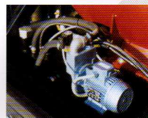
Автоматическая перекачка топлива из внешнего резервуара
